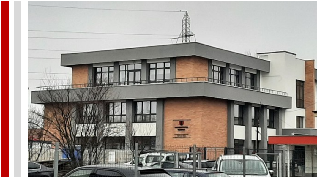
fig. 1 – Noul corp de clădire de la Extensia univ. Alba Iulia
